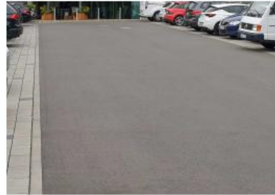
BEREICH: Straße, Vorplatz, Zufahrt Asphalt
