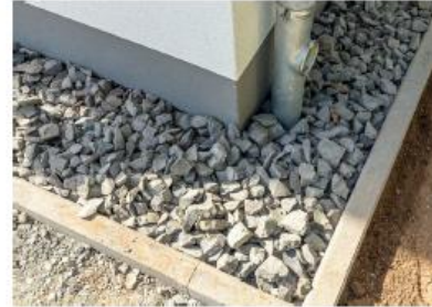
BEREICH: Gebäudekanten Kiestraufe
