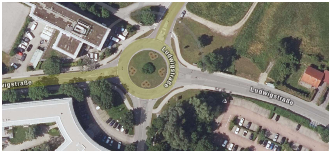
Abbildung 5: Luftbild Kreisverkehr Ludwigstraße/ Am Söldnermoos/ Nordumfahrung (Quelle: Bayerische Vermessungsverwaltung, 2024)
